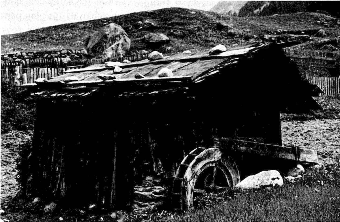
Il fallun da Sep Truaisch a Fuorns. La canal pusada silla rod'aulta mantegn la paretta. Foto da Paul Caminada, Thalwil.
