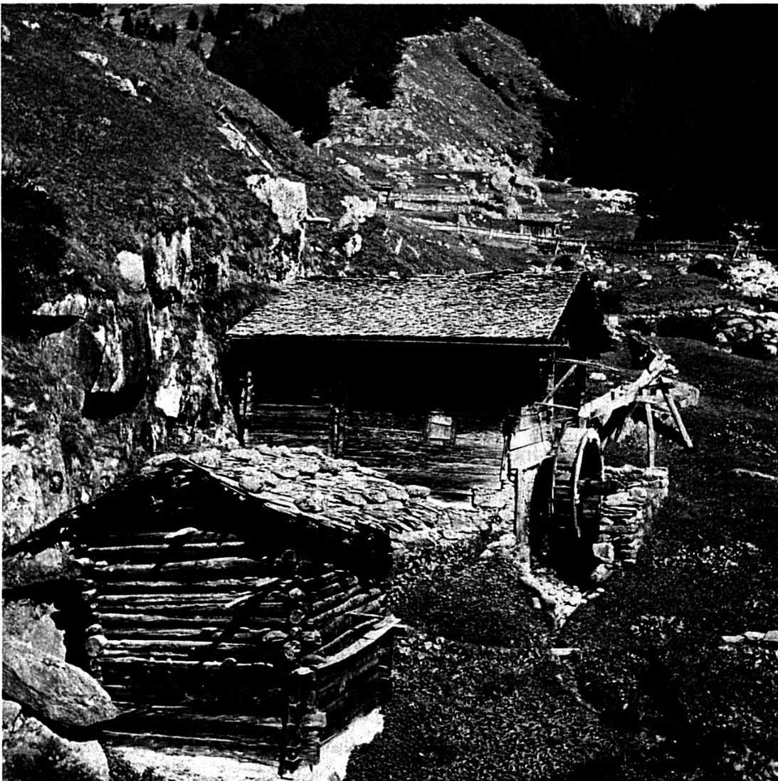
Mulin dils Bearths a Fuorns cugl indrez da better giu l'aua, dasperas il clavaziel e sur la via vedra il fallun. Foto Furter, Tavau.
