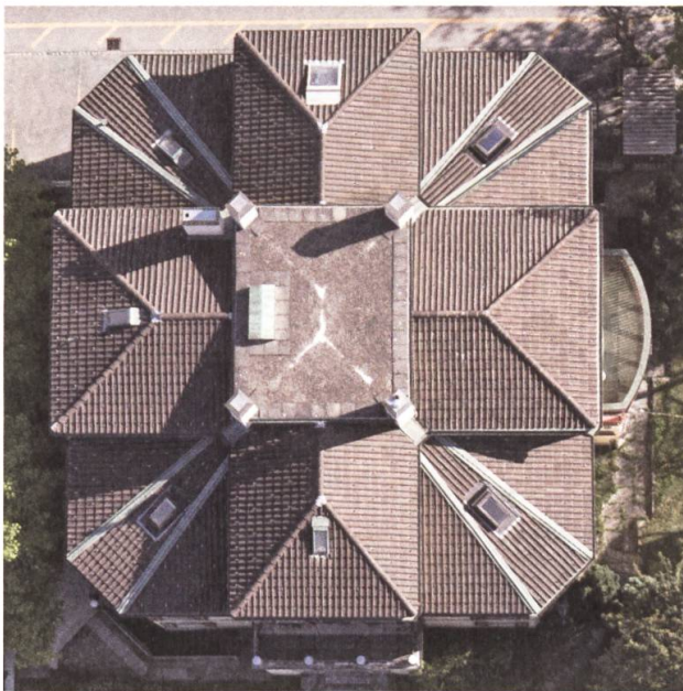
Vista da surengiu cun il tetg plat, ils quatter risalits centrals ed ils quatter chantuns
