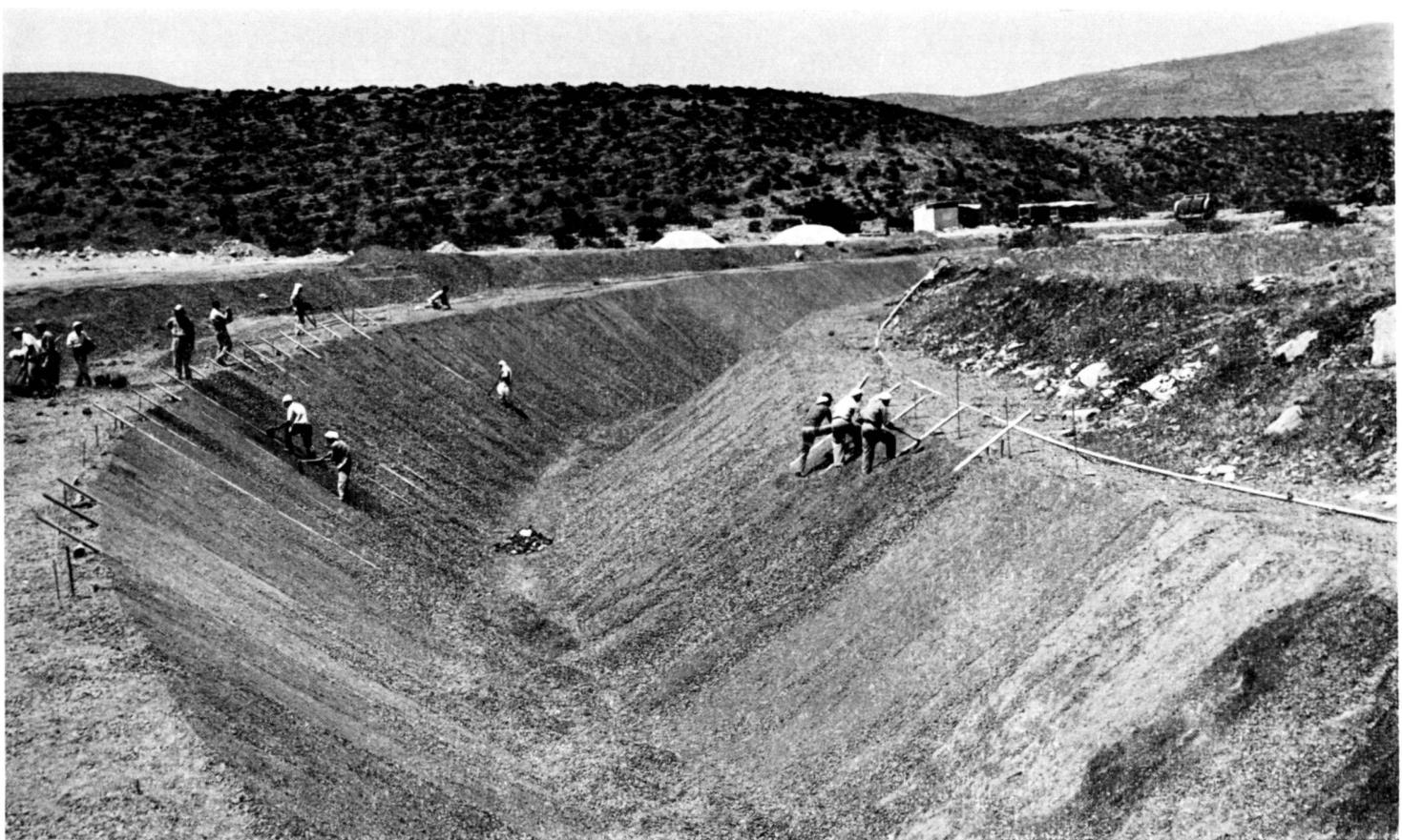
Eine Baustelle der transisraelischen Wasserleitung, welche das Wasser aus dem Tiberiassee entnimmt, in mehreren Stufen ca. 700 m hoch pumpt und mit einem Gefälle von 1,6 % rund 300 km nach Süden in die Negev-Wüste fliessen lässt. Die Endleistung der Leitung ist auf 10 m<sup>3</sup> pro Sekunde berechnet. Offener Kanal, der zum Ausbetonieren vorbereitet wird.
