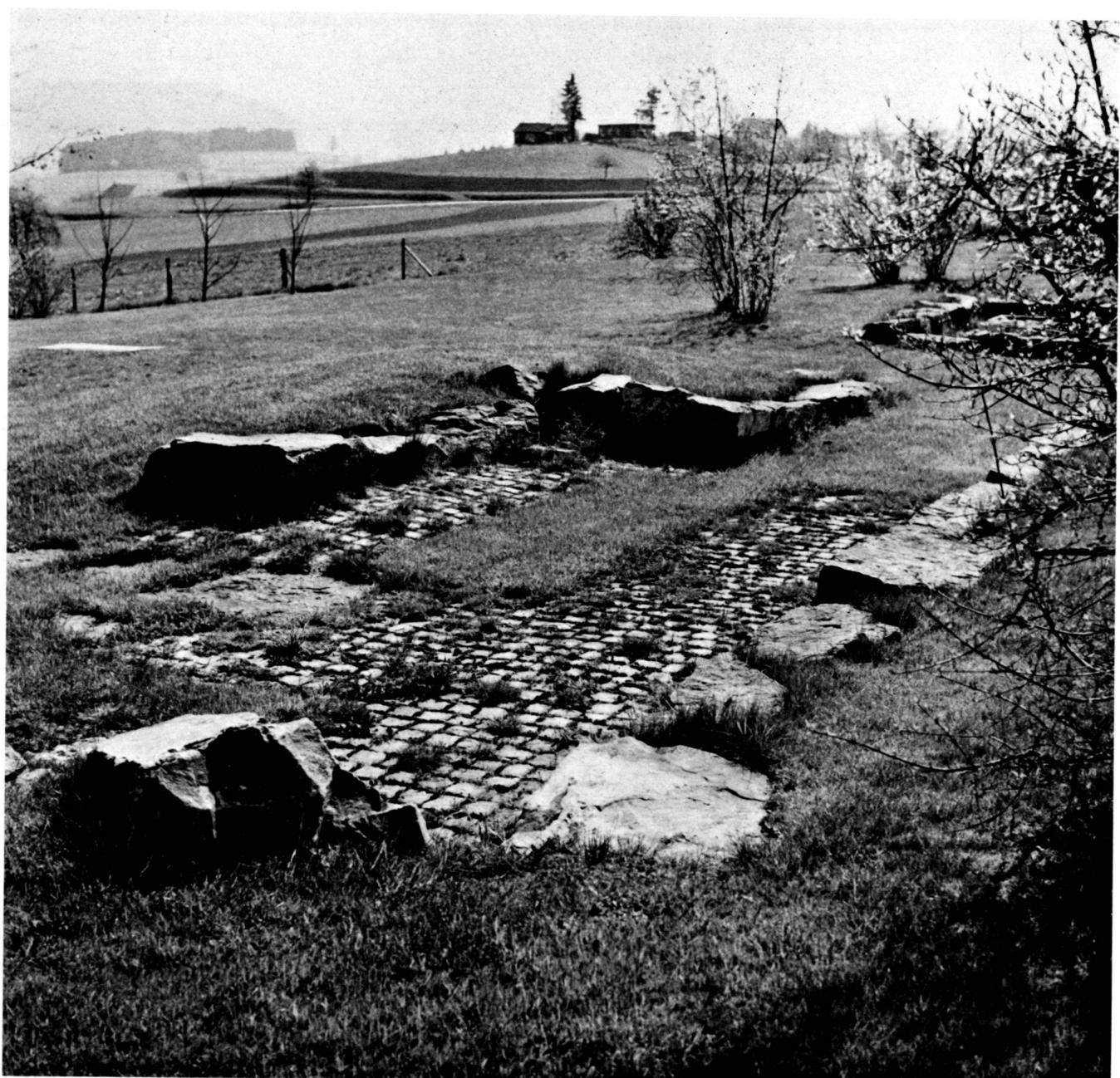
Dem Bauherrn sind diese Bruchsteine als Geschenk zur Verfügung gestellt worden. Da es sich dabei um ein sehr hartes Material handelt, wurden diese bruchrohen Felsblöcke ohne jede Bearbeitung versetzt. Den massstäblichen Kontrast bilden die locker verlegten Pflästersteine und die weiche Modellierung der Anschlussflächen.
