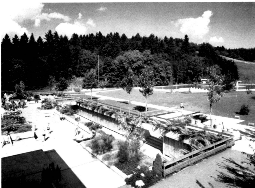
Abgang von den Garderoben von Südwesten. Sortie des garderober, vue du côté sud-ouest. Ramp of the dressing booths from the South-west.
