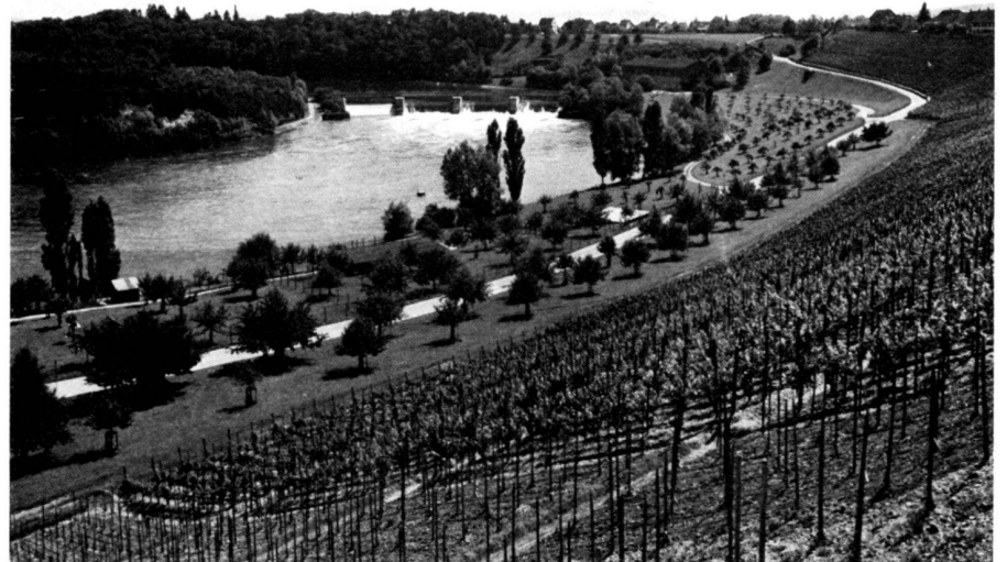
Blick flussaufwärts auf das harmonisch in die Kulturlandschaft eingebettete Kraftwerk mit Stauwehr und seitlich angeordnetem Maschinenhaus. Bild: Klaus Leder
