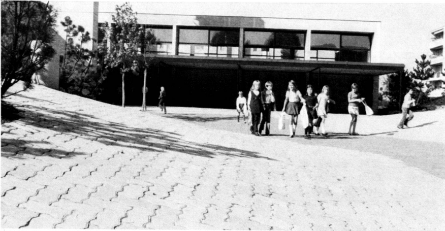
Pausenplatz des Primarschulhauses «Feldhof». Blick in Richtung Spezialtrakt mit gedeckter Pausenhalle. Pflasterung der hügeligen Bereiche mit grauen, in den Mulden mit schwarzen Verbundsteinen. Bild: G. Engel
