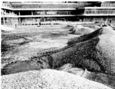
1 Nackter Beton auf dem IGA-Gelände in Hamburg.
