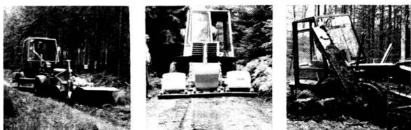
mit Fräse vorn... und Vibrator hinten beim Grabenziehen
