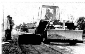
beim Bitumen-Einbau
