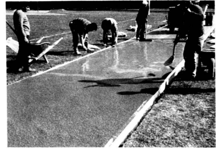
Erstellen des Endbelages (sog. Topping/Deckschicht)
