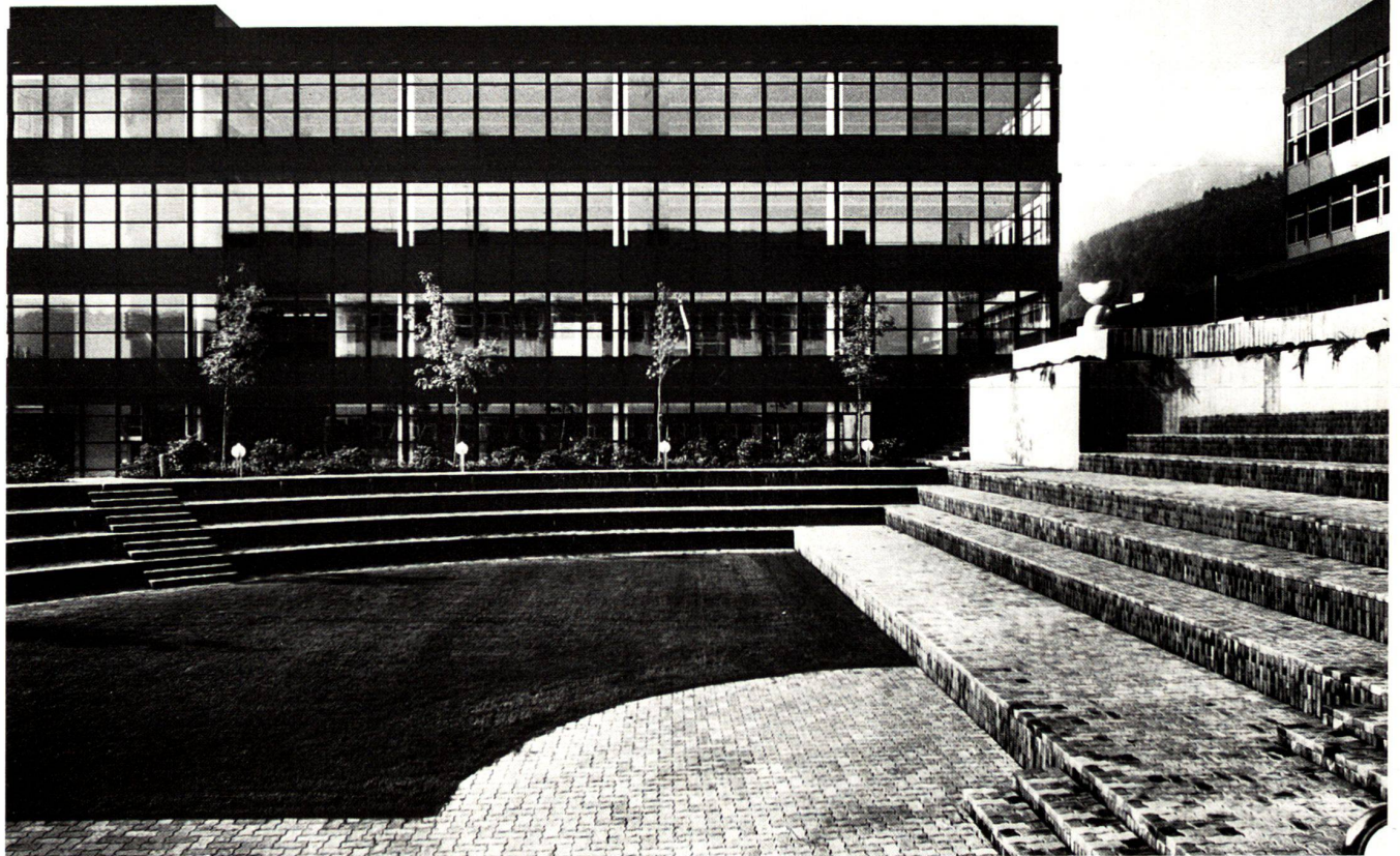
Teilansicht des Innenhofs des Zentralschweizerischen Technikums in Horw. Bild: Ege Industrierwerbung, Luzern
