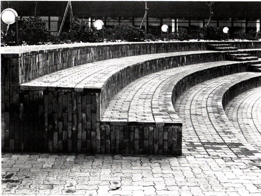
Detail vom Sitzstufenaufbau im Innenhof des Zentralschweizerischen Technikums in Horw. Bild: Max Hermann, Stansstad
