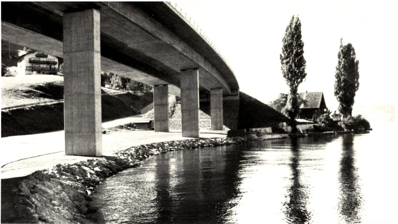
N 4 am Zugersee. Der Strassenbautechnik unterworfenen Uferlandschaft. Beispiel einer Ambivalenz der Formen. Bild: W. Roelli
