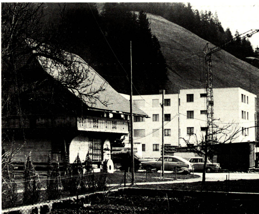
Zu hohe Ausnutzungsziffern und eine rücksichtslose, architektonisch minderwertige Bauweise zerstören vielerorts das Ortsbild und die Landschaft. Bild: R. Schneider
