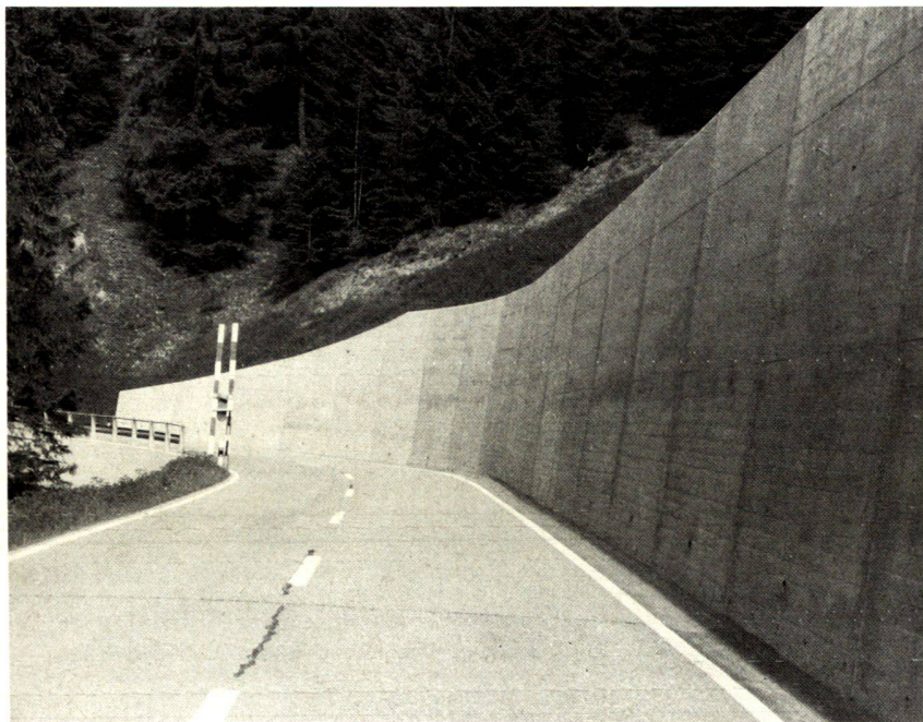
Landschaftszerstörender Strassenbau. Ueberdimensionierte Betonstützmauern (Strasse nach Wiesen/GR). Bild: H. Weiss
