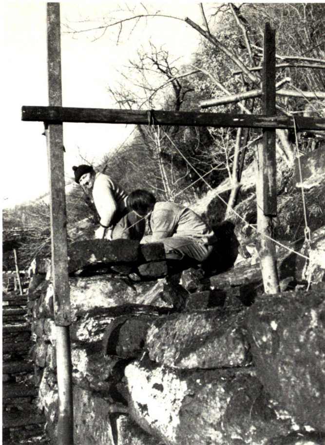
Oben links: Eine wichtigste und erste Massnahme für die Einfügung eines Wohngartens in den Abhang war die Erstellung einer orts- und materialgerecht gearbeiteten Stützmauer.
