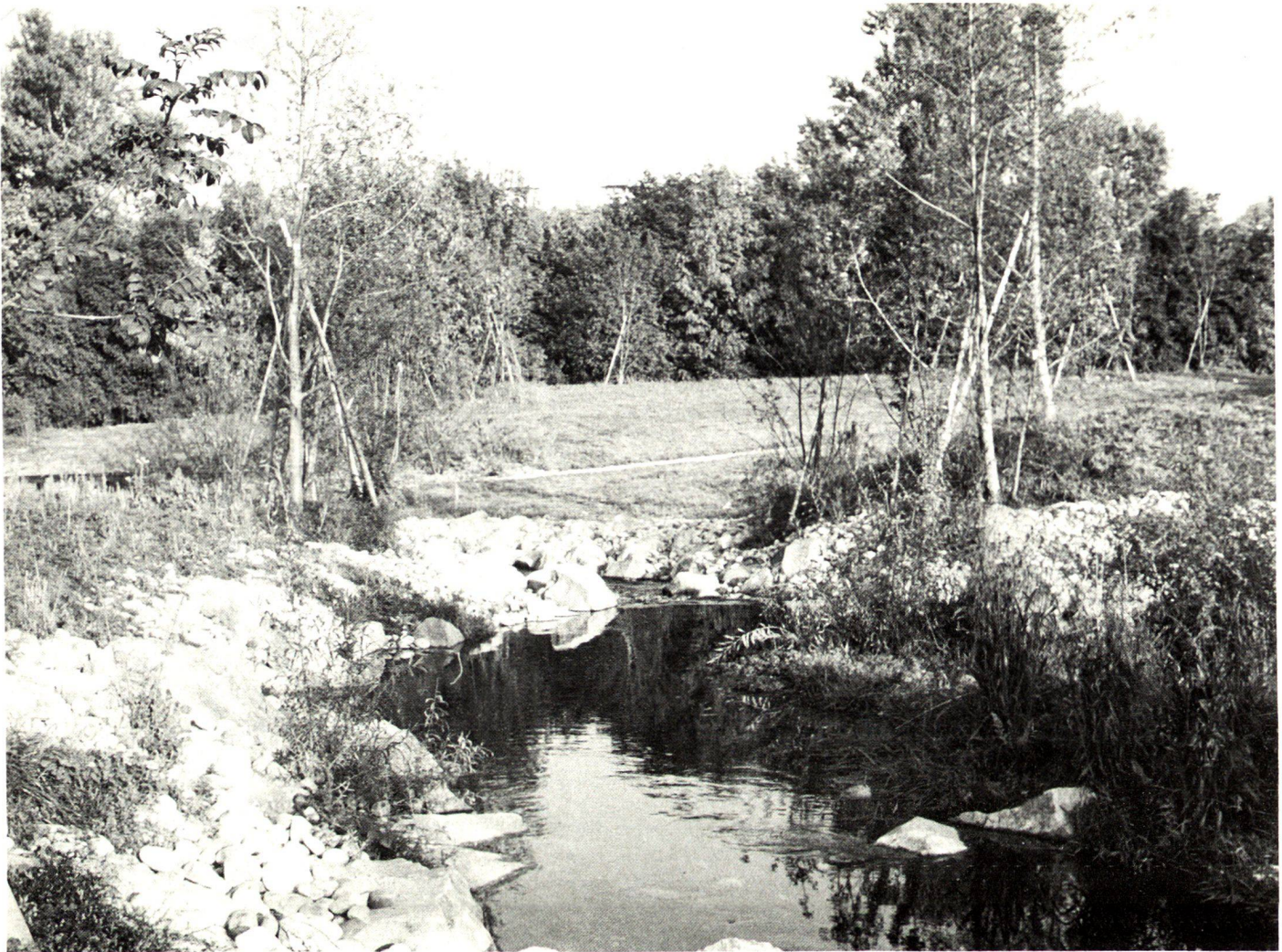
Linienführung, Bepflanzung, Ufer- und Sohlenbefestigung des neu entstandenen Bachs sind nach ingenieurbiologischen Gesichtspunkten geplant und ausgeführt worden.
