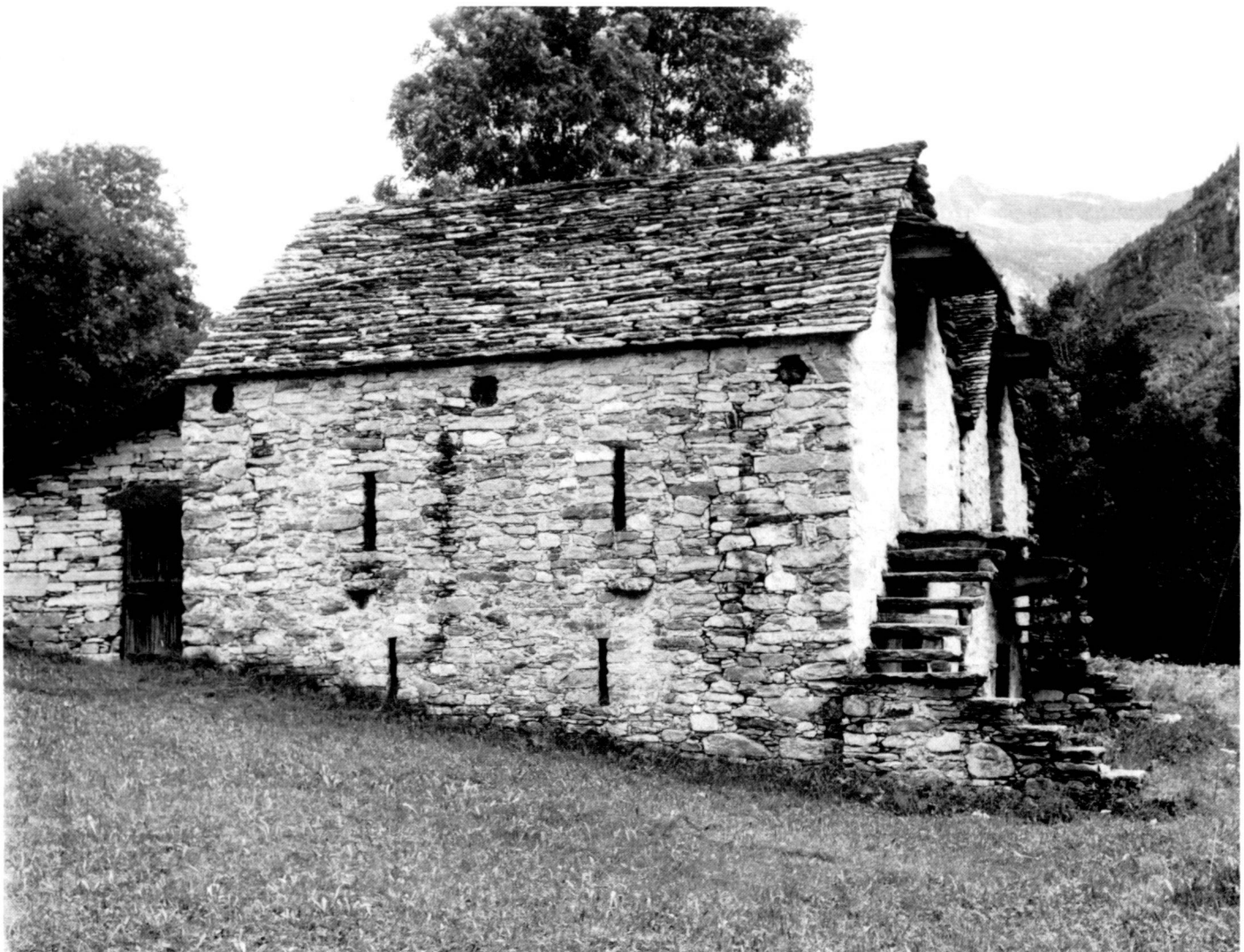
Zweigeschossige Häuser im Valle Verzasca, Tessin.
