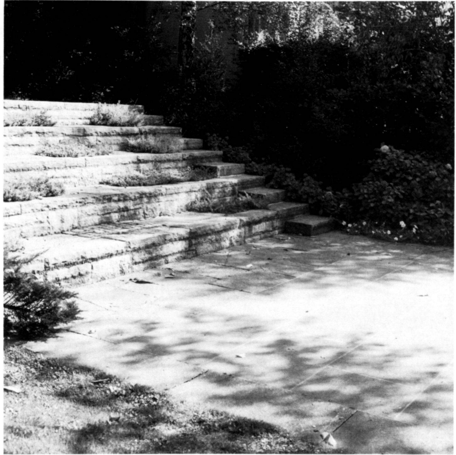
Utilisations de la pierre naturelle dans un parc vers 1950. Use of natural stone in a park around 1950.
