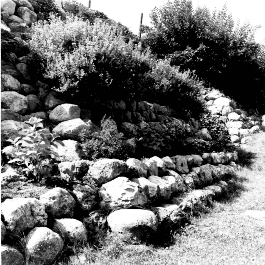
Böschungsgestaltung mit Steinblöcken (1962).
