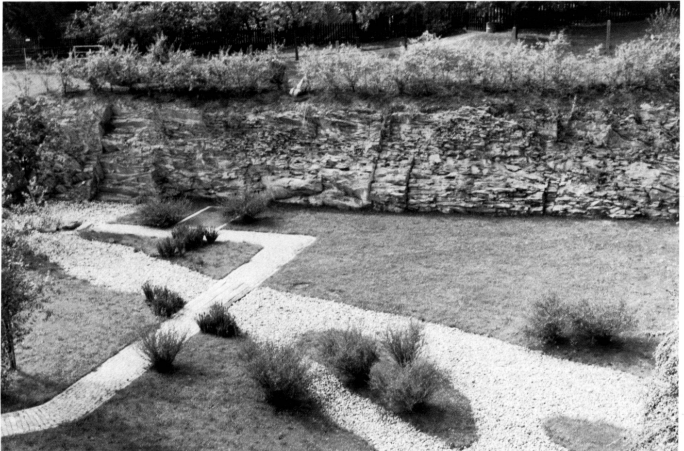
Garten zum Büroneubau der SUVA in Luzern. Bruchrohe Wand aus anstehendem Sandstein anstelle einer Betonmauer (1967).
