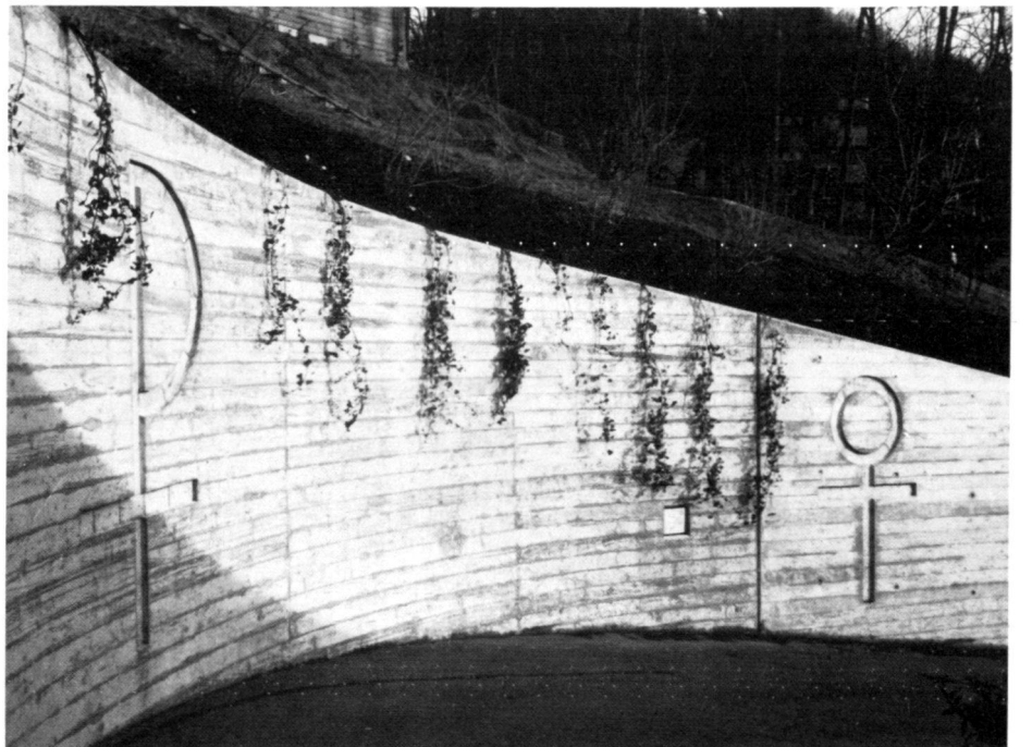
Stützmauer im Friedhof Horw. Foto Mondo Annoni, Emmenbrücke Mur de soutènement du cimetière de Horw. Photo Mondo Annoni, Emmenbrücke Supporting wall in Horw Cemetery. Photo Mondo Annoni, Emmenbrücke
