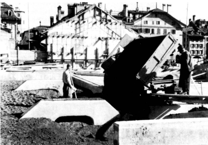
Links: Zufuhr von Erde beim Bau des Casinogarage-Dachgartens im Jahre 1936.
