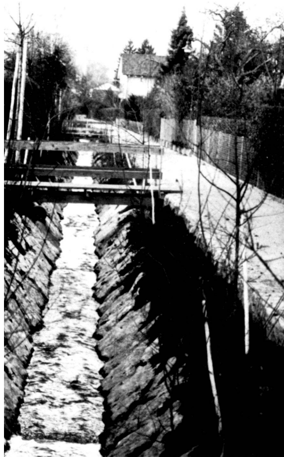
Abb. 10: Sohlenschutz des neuen Gerinnes mit Schroppen aus Lägernkalk.
