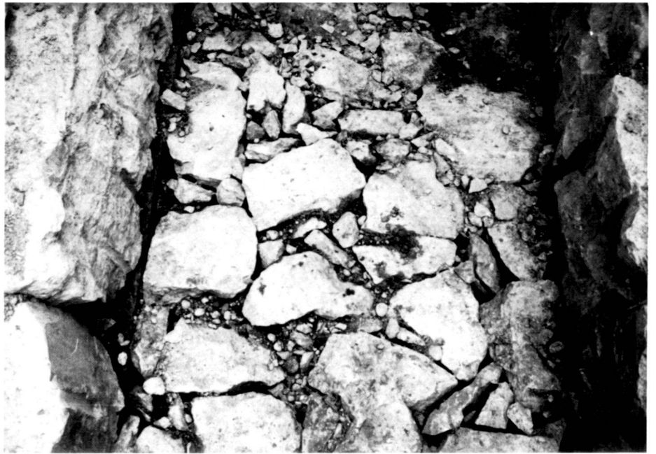
Abb. 10: Sohlenschutz des neuen Gerinnes mit Schroppen aus Lägernkalk.
