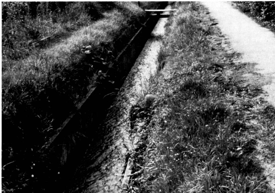
A gauche: Fig. 2: Partie couverte du Gottesgraben. A droite: Fig. 3: Etat du Gottesgraben avant la rénovation.
