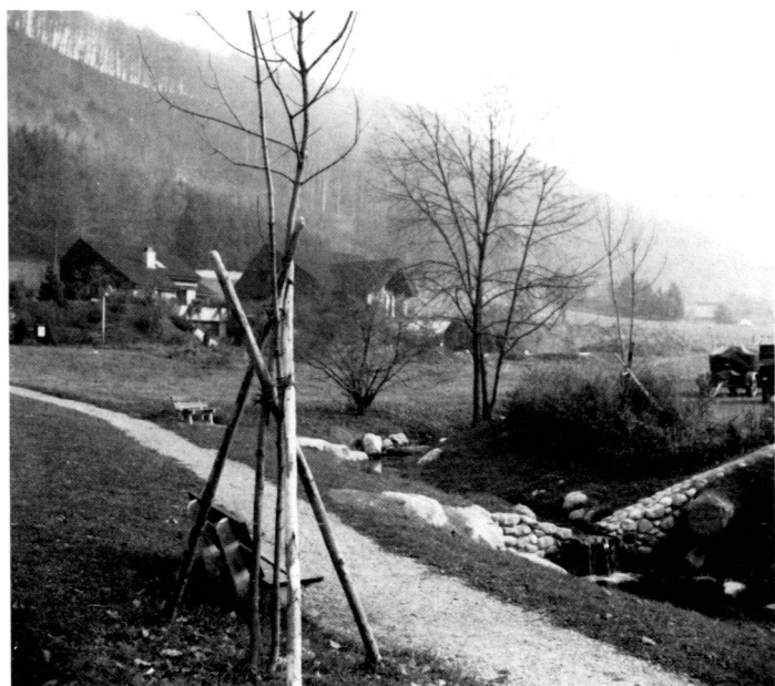
Links: Eines der gemauerten, hohen Schwellenbauwerke mit Tosbecken und Fischunterschlupf. Links der Spazierweg mit Naturbelag und Sitzbänken des Verschönerevereins.
