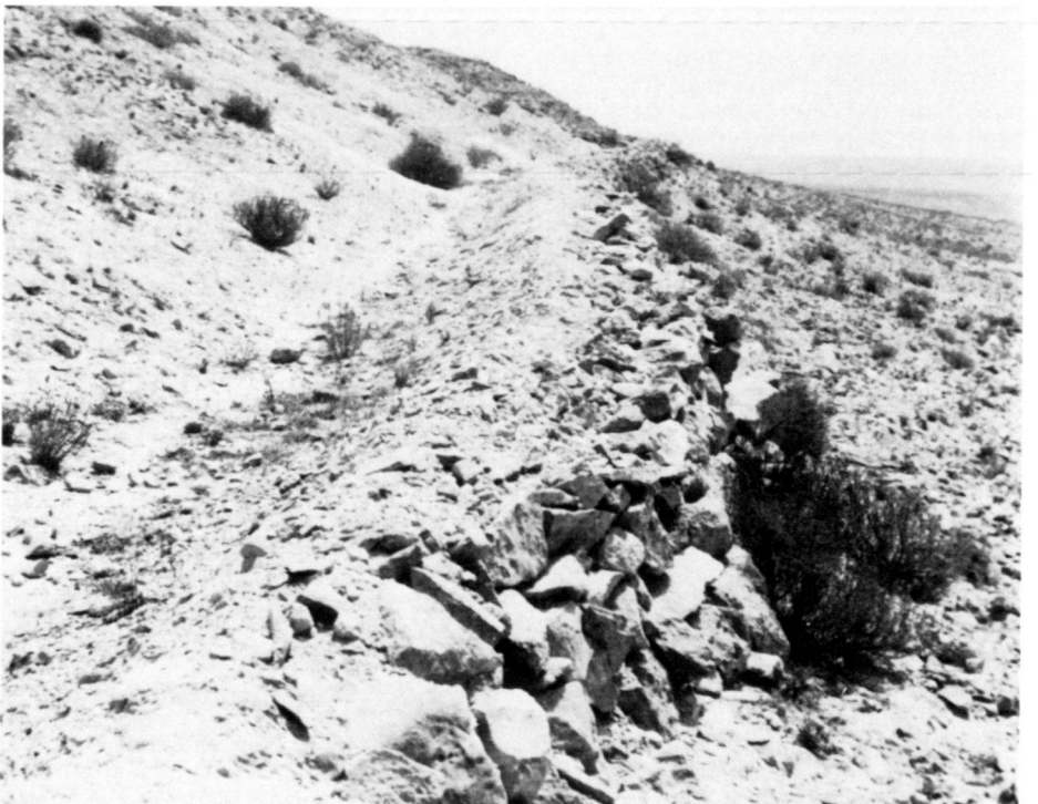
Queransicht eines Zuleitungskanals, der das Flutwasser von den Hängen sammelt und aus dem Sammelgebiet in die Farmeinheiten leitet. Vue transversale d'un canal d'aménée qui recueille l'eau de ruissellement des pentes et les conduit vers les fermes. Cross-section of a supply channel which collects the flood waters from the slopes, and leads it from the collecting area to the farming units.
