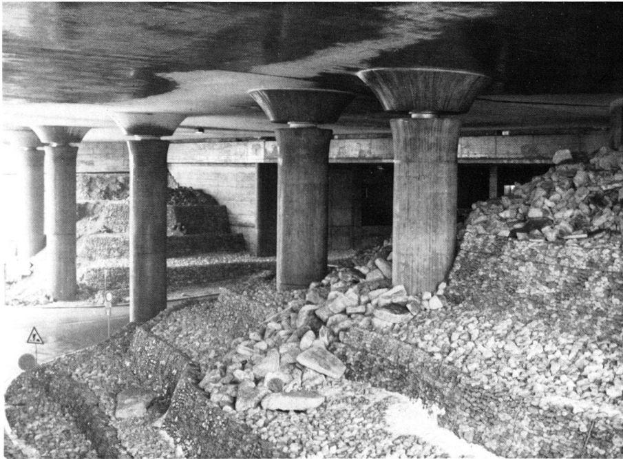
Unter der Brückenplatte: «Unterirdische Landschaft» mit Zufahrt zur Universität und zum Parkhaus.
