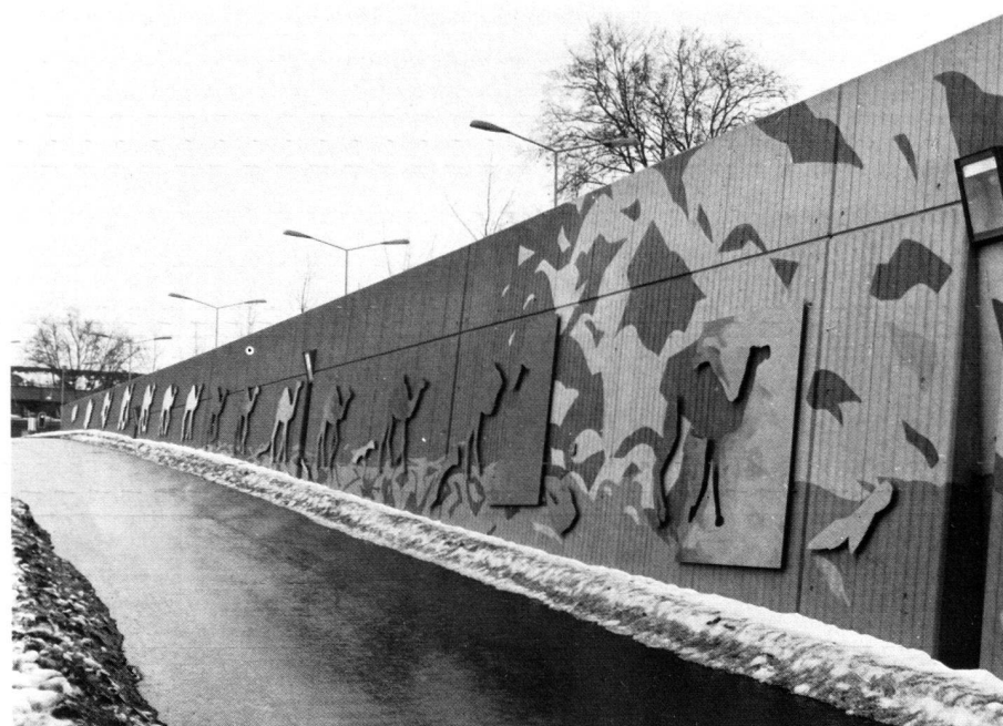
Stützmauergliederung mit Schlitzen (Nischen für Kletterpflanzen und Beleuchtung). Künstlerische Gestaltung: St. Kauffungen.
