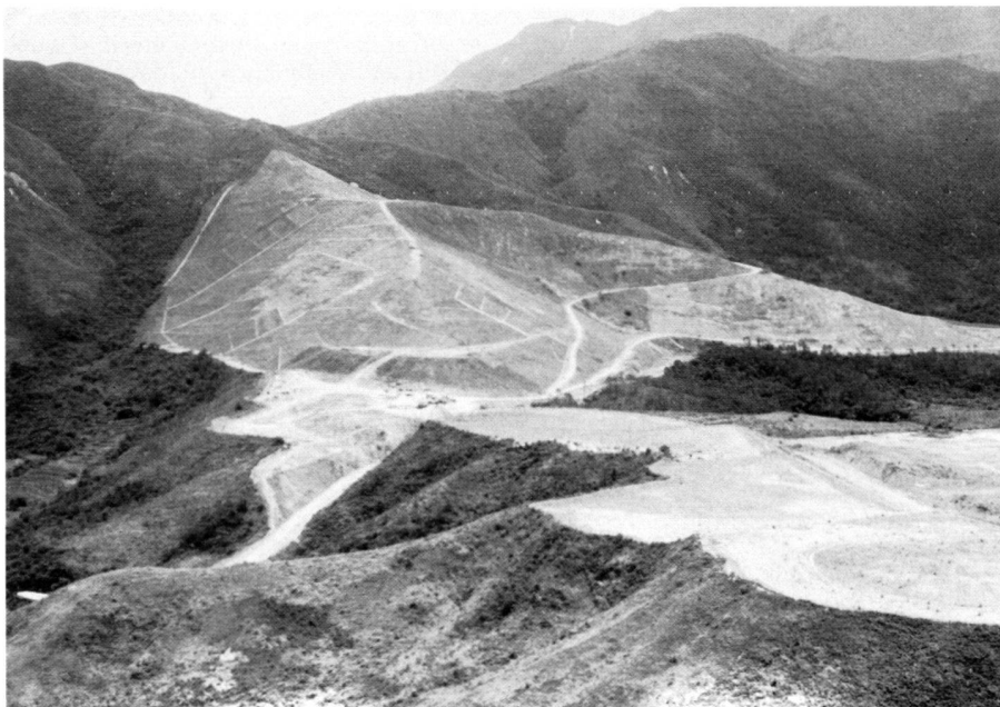
Pat Sin. J im Vordergrund, K im Hintergrund, nachdem man ein Entwässerungssystem angelegt hatte. Foto: GCO
