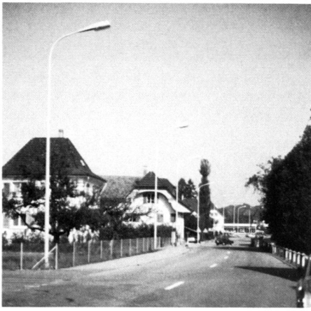
Links: Auf eine taghelle Ausleuchtung mit Peitschenkandelabern sollte verzichtet werden, eine Orientierungsbeleuchtung, z. B. an Hausecken, genügt vollauf.
