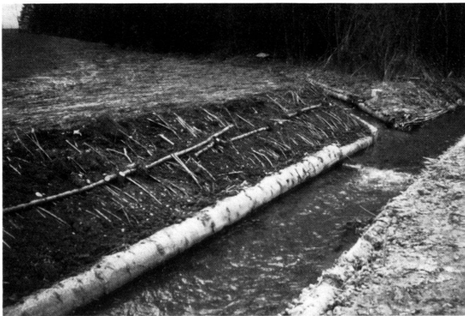
5 Links, Spreitlage mit Tannenbalken als Fussicherung; rechts, 2 Tannenbalken mit Buschlage dazwischen.
