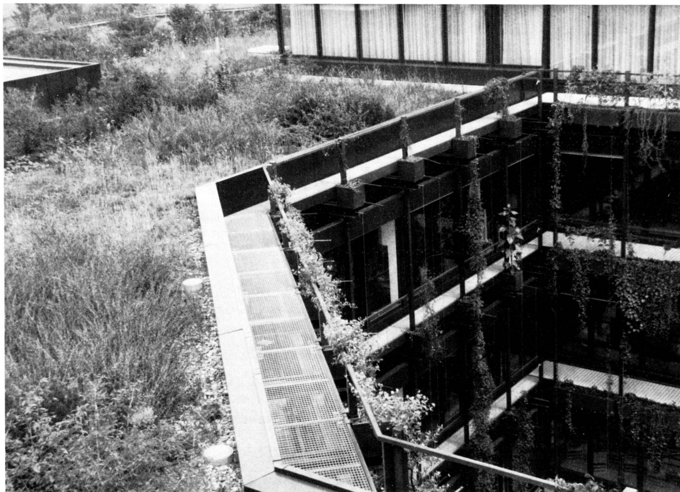
Zusammenhängende Begrünung vom Erdgeschoss über die Fassaden bis hin zum Dach.
