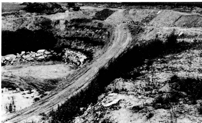
Links: Wiederaufbau einer Böschung mit Buschlagen, am Fuss Schaffung eines Spezialstandortes mit Steinblöcken, an anderen Stellen wurde eine mindestens 0,5 m starke Sandschicht bis in mittlere Böschungshöhe gezogen. Von der Bepflanzung der Böschungskrone sind nur 2 Eichen gut erkennbar.
