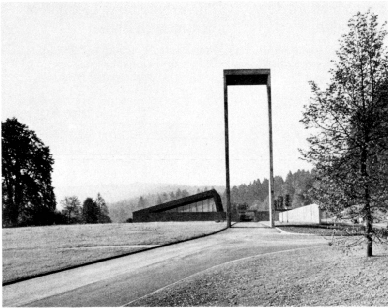
Links: Zustand des Haupteinganges mit der Erweiterung von 1957 (Architekten E. + R. Lanners, R. Wahlen, Zürich; Fotoreproduktion aus «Werk» 10/1959).
