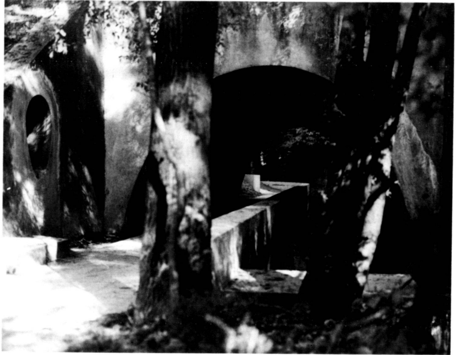
Fussgängerpassage – Weg unter der Strasse. Foto: J. Gerbert Passage pour piéton – voie passant sous la route. Pedestrian passage – pathway beneath the road.
