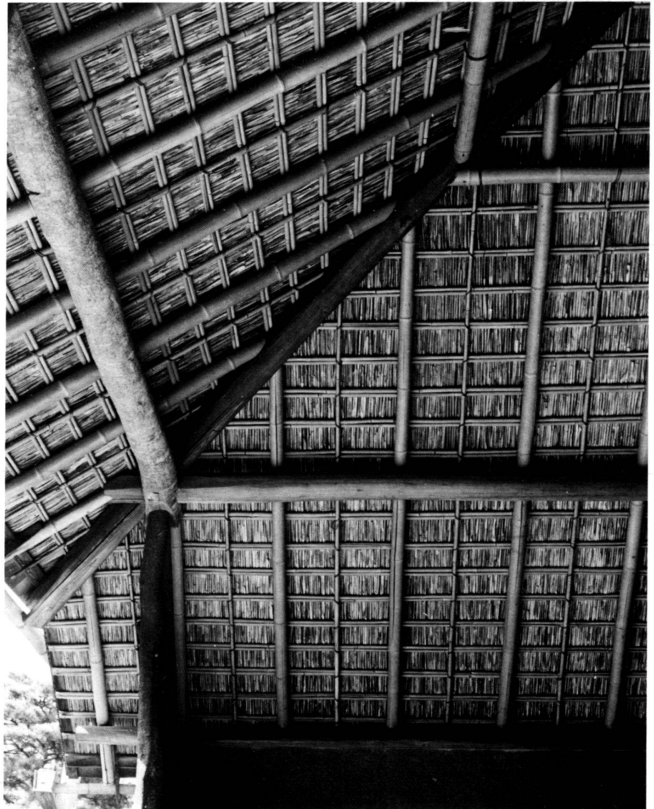
Gepparô, der Pavillon der Mondwellen mit Bambusdachkonstruktion über dem offenen Raum.
