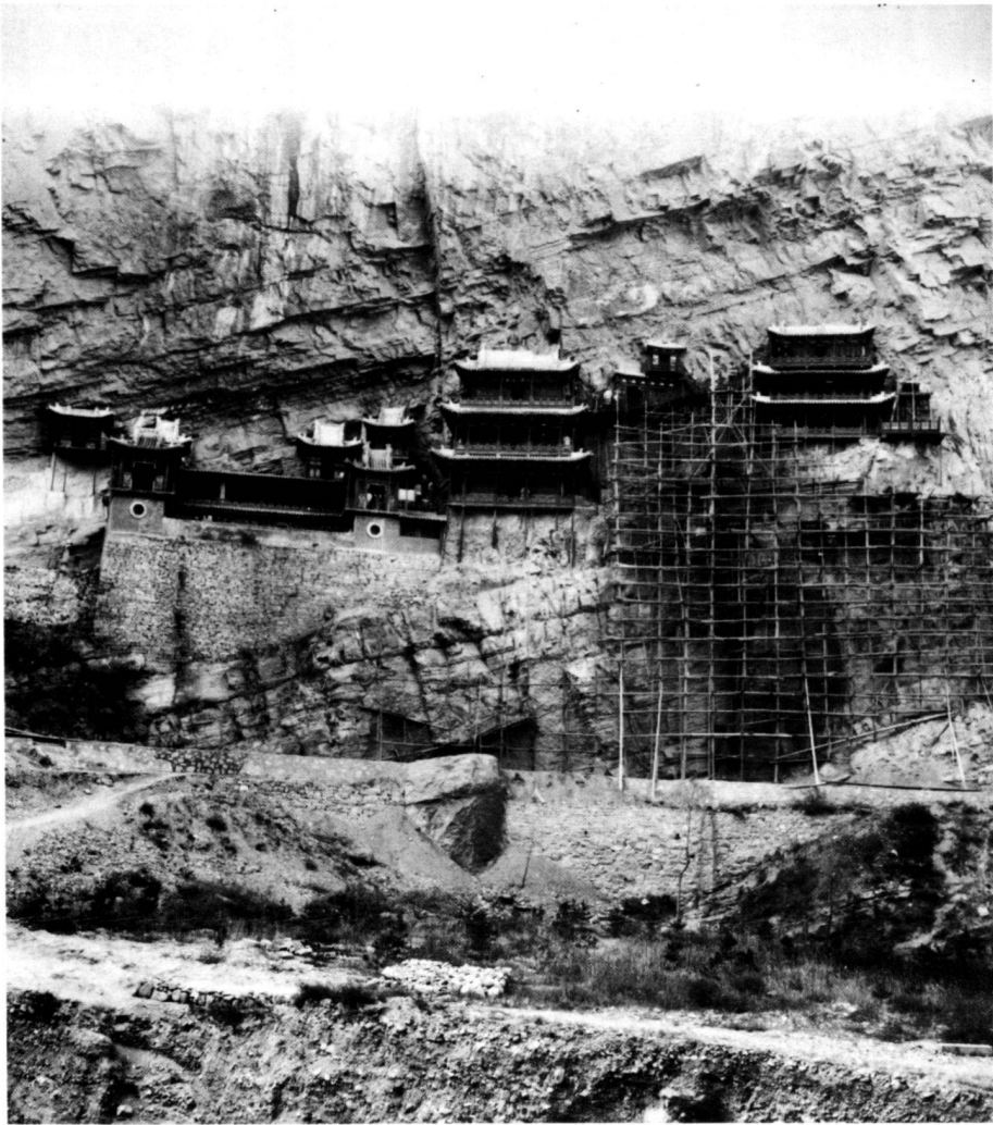
Das Hängende Kloster Yuan-Kong-si am Hengshan (Provinz Shanxi). Das Gerüst, in den Fels eingebaut, ist vollständig aus Bambusstangen konstruiert.
