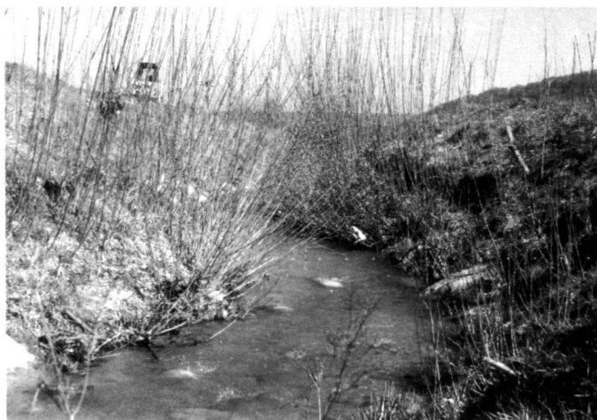
Links: Ufersicherung mit Faschinen-Spreitlagen-Kombinationen (1 Jahr nach Einbau).
