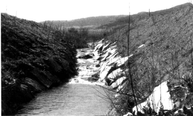
Links: Unterster Bachabschnitt mit steilen, hohen Böschungen. Tiefer Geländeeinschnitt zur Überwindung der Niederterrassenkante.
