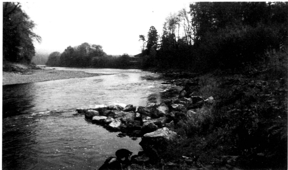
A gauche: Le tronçon aval avec ses épis après une période de végétation.
