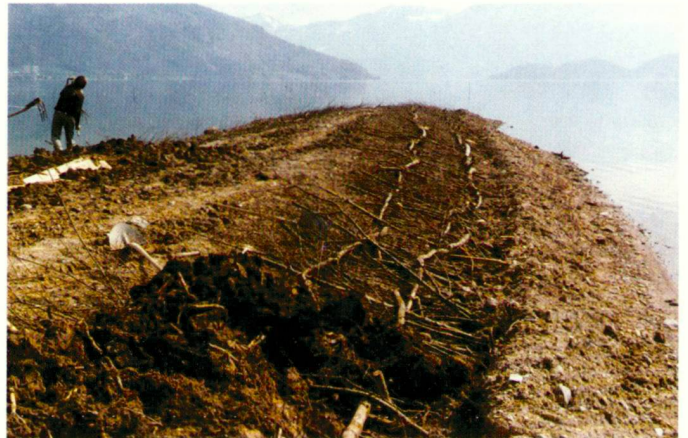
Travaux de pose de pieux d'aménagement des rives.
