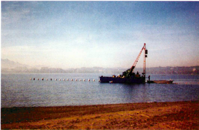
Pfählarbeiten und Spreitlagenbau.
