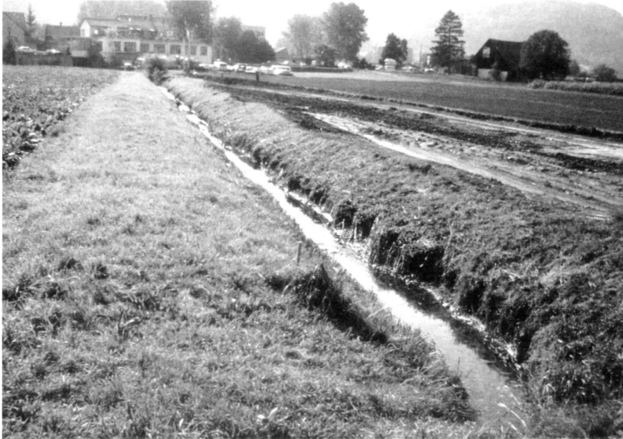
Links: Bei Verlegung und Ausbau dieses Baches wurden kompakte Abschnitte der schmalen Hochstaudentäme paketweise entnommen und zur Wiederverwendung zwischengelagert (etwa 6 Monate). Foto: H. D. Koeppel
