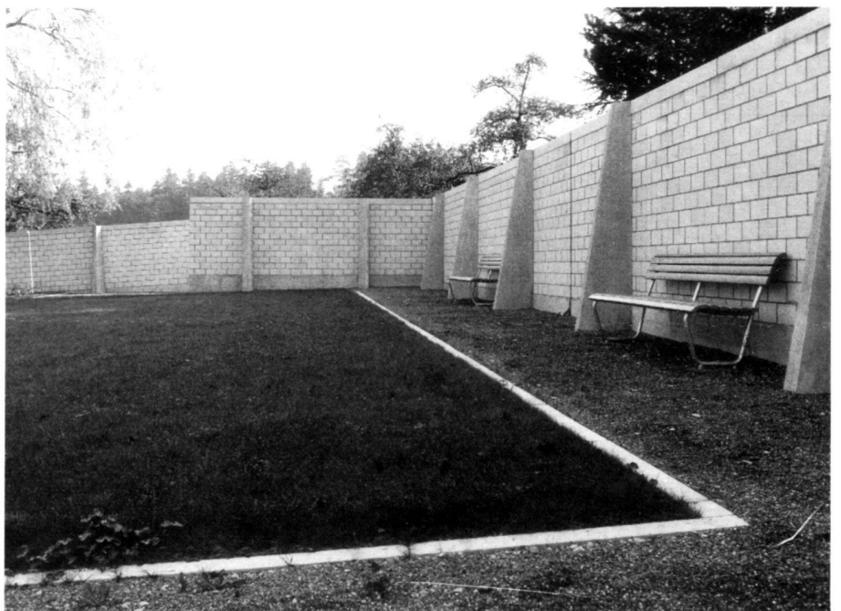
Neue Mauer mit Grabfeld. Foto: F. Bochud, Zürich Nouveau mur avec champ de tombes. New wall with grave area.
