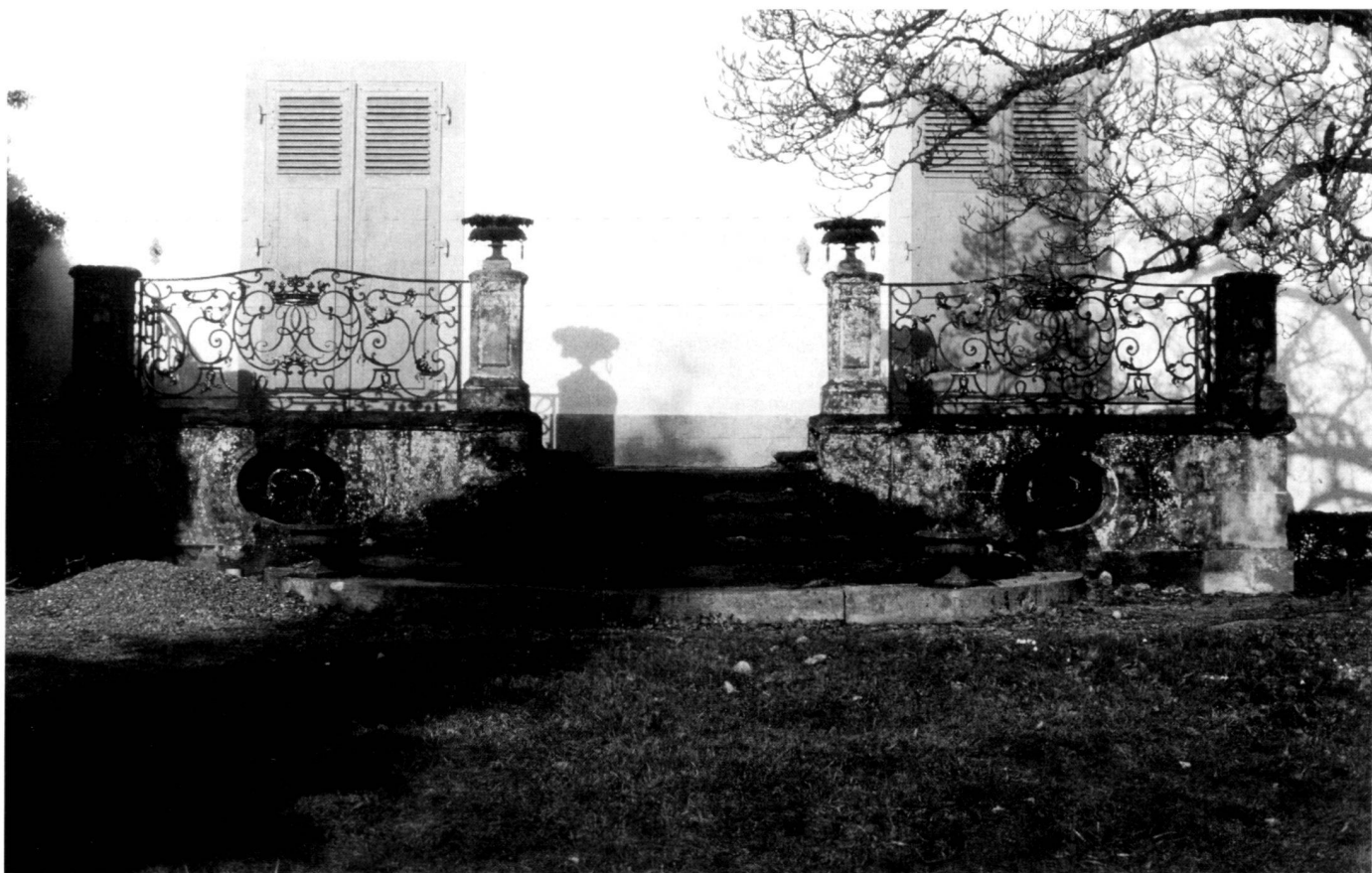
Um 1900 hat Architekt Beat von Fischer aus Bern den bisher einfachen Garten an der Schmiedgasse in einem aufwendigen Neobarockstil umgestaltet. Dazu gehört auch die Freitreppe, die zum gleichzeitig neugestalteten Gartensaal führt.
