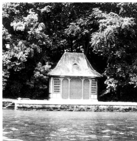
Protection des nombreuses petites constructions précieuses qui déterminent la vue de la rive, comme les maisons de bateaux, les pavilions, les débarcadères, etc. (Horw).
