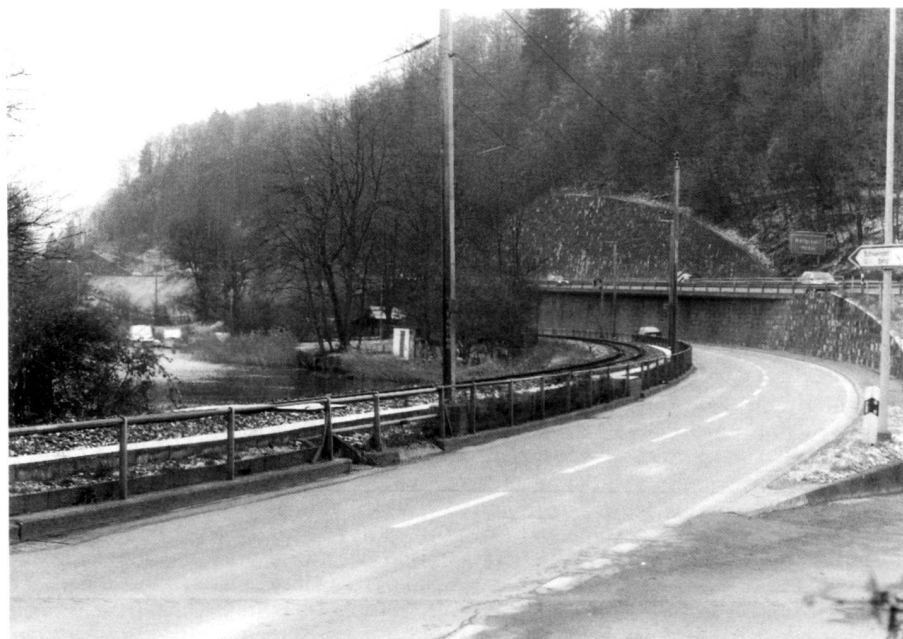
Abb. 3. Bestehende Situation bei Ennethorw, rechts oben Autobahntrasse.
