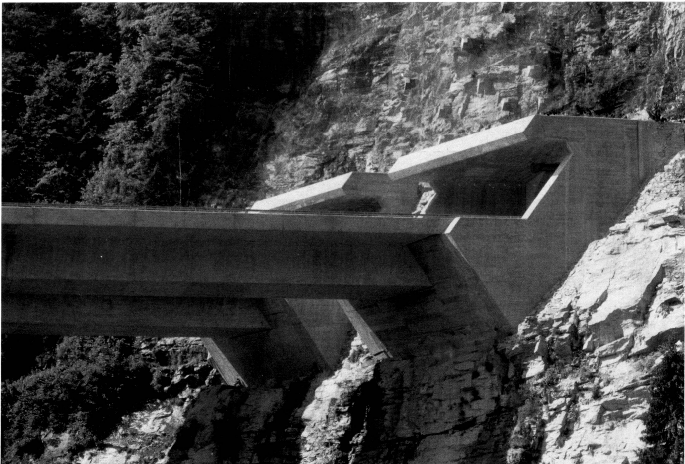
Testa di ponte autostradale a Faido. Arch. FAS Rino Tami.
