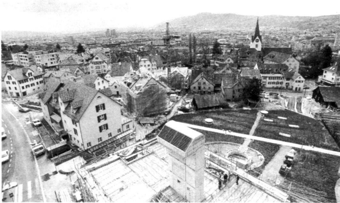
Die Tiefgarage im Bau. Vorne: der im Dach «integrierte» Abluftkamin. Auf der Scharrerwiese sind die Fundamentarbeiten und die Humusierung abgeschlossen. Wenig ist dem Zufall überlassen. Foto: Schwaiger
