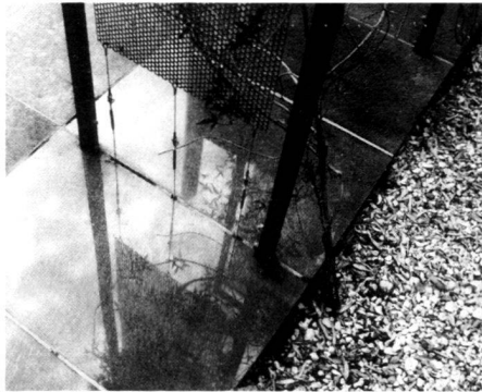
Links: Rankgerüst als Installation, Stahlrahmen, Lochblech, Granit poliert.
