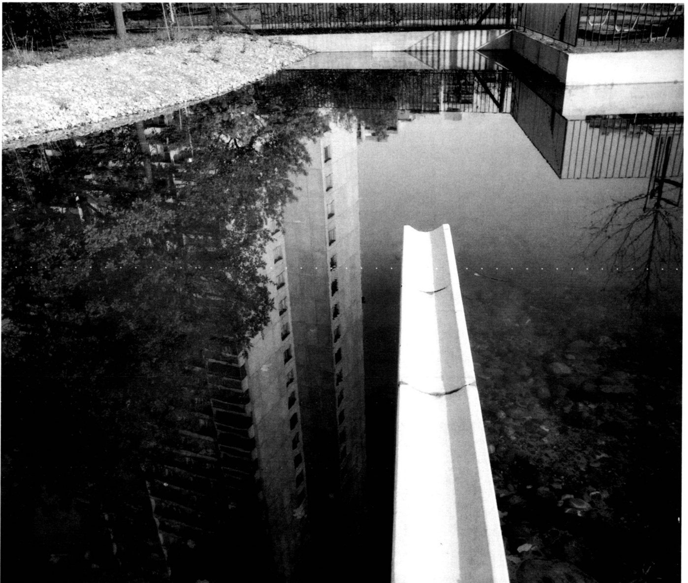
Im Bereich des Kindergartens fliesst das Dachwasser über offene Betonrinnen in den Weiher.
