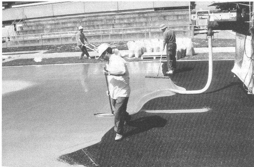
Aufbringen des Polyurethan-Bindemittels. Foto: Urs Schöni
