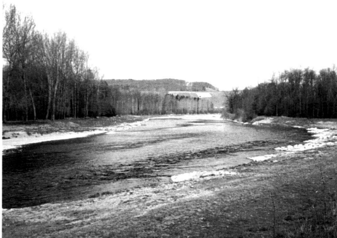
Abb. 5 und 6: Etape III. Nach einer grosszügigen Profilaufweitung und Vorlandabsenkung entstanden Kiesbänke, die sich immer wieder umlagern (links 1992, rechts 1993).
