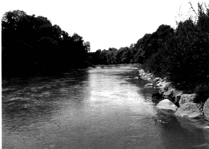
Abb. 1 und 2: Etape II. Blick flussabwärts: vor dem Bau (1989) und etwa drei Jahre nach Bauende (1994). Fotos: asp
