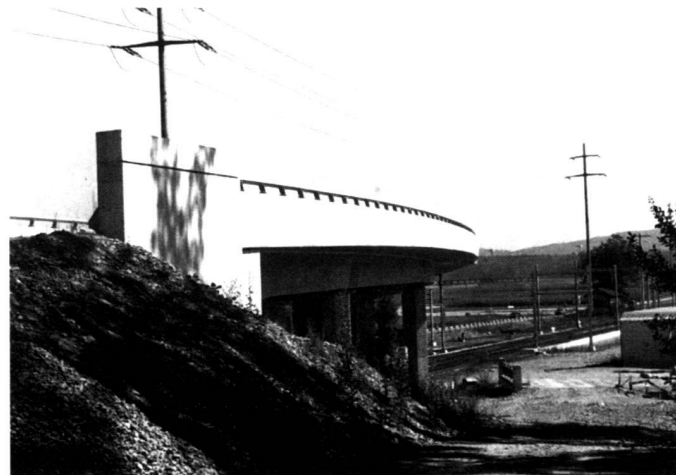
Brückendetail, Postament/Knsockopf/Geländer. Détail d'un pont: piédestal/tête de console/garde-fou. Bridge detail, pier/corbel/railings.
