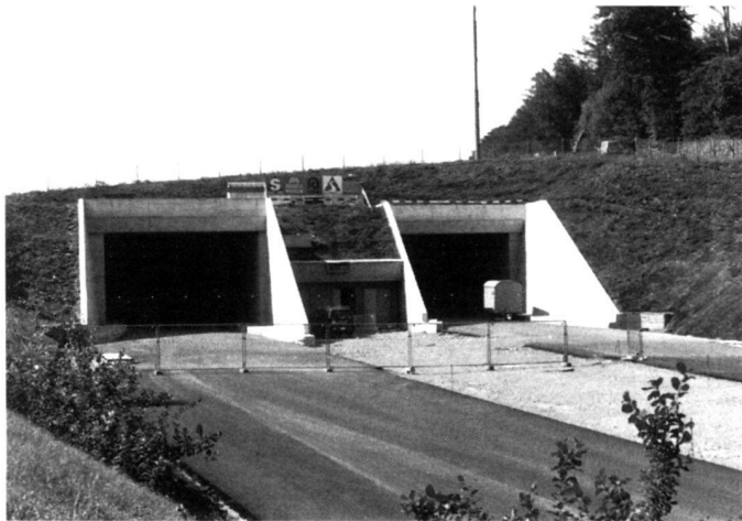
Habsburgtunnel Südportal. Portail sud du Habsburgtunnel. Habsburg Tunnel southern portal.
