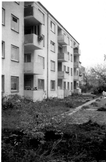
Aufschüttung. Remblai. Filling-up.
