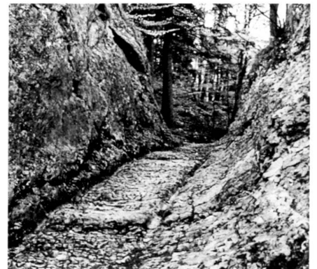
Langenbruck, Oberer Hauenstein (BL). Dieser Hohlweg mit Karrgeleisen wurde schon in römischer Zeit in den Fels gehauen. Foto IVS: Hp. Schneider
