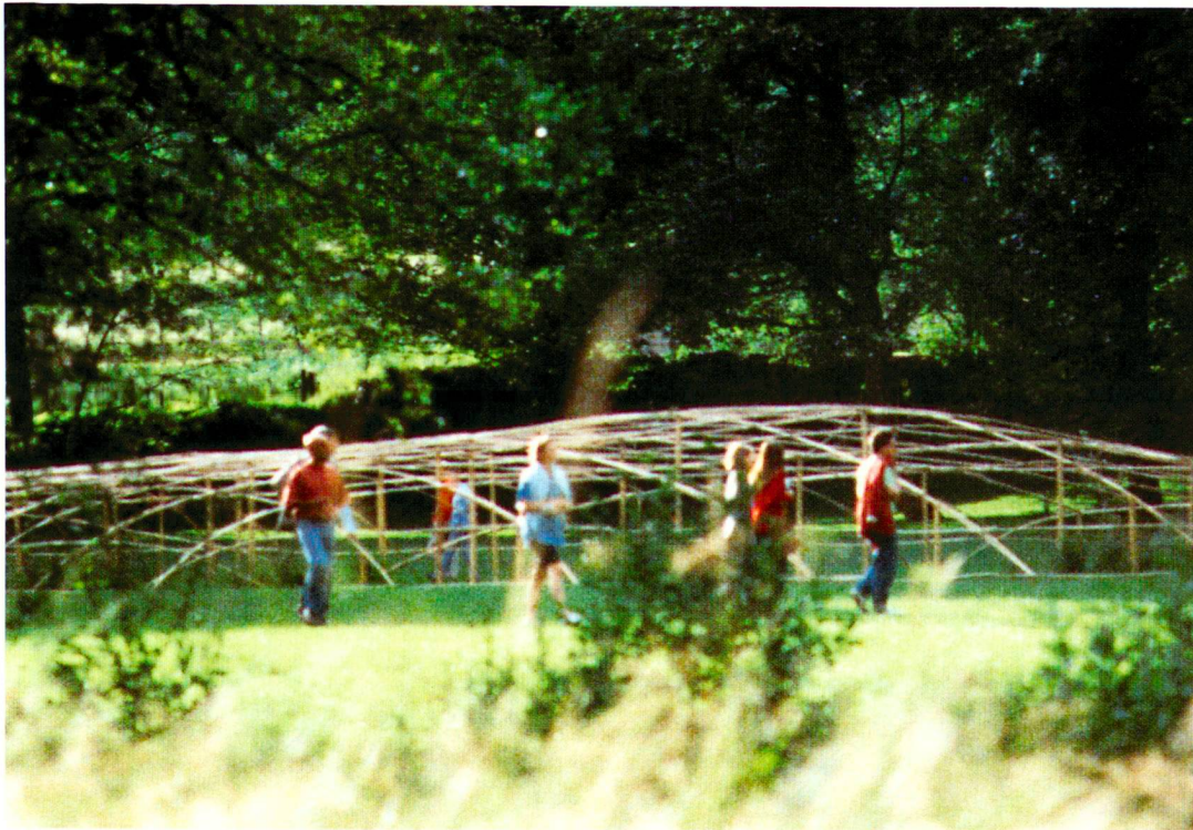
Das Bambusgerüst für das «Pièce d'eau»
